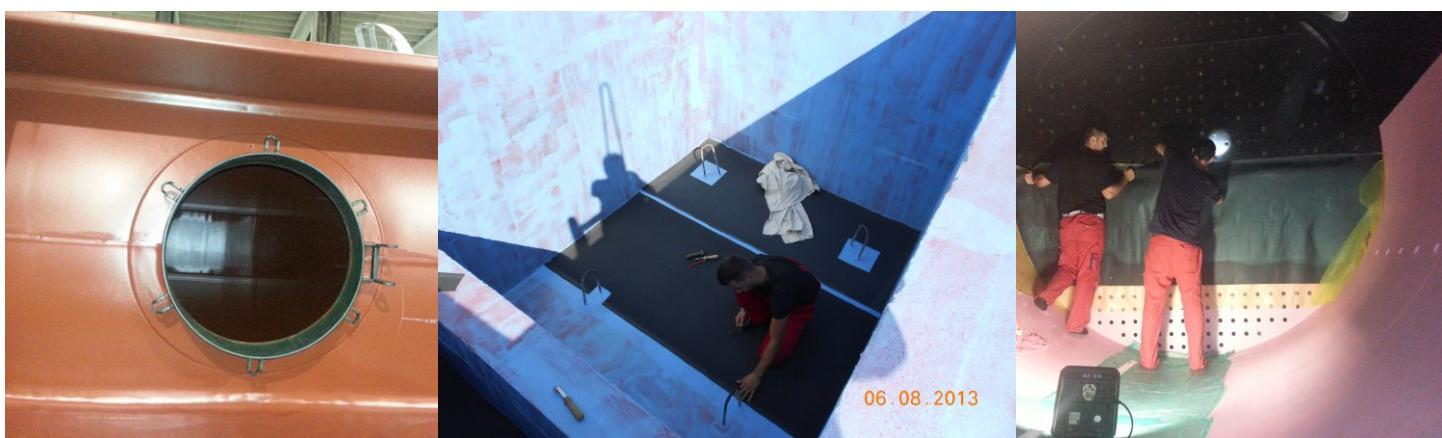
Partile metalice expuse atacurilor chimice puternice, mecanice si socului termic, ca bazine de stocare, celule de filtrare, tanuri de amestec, vase pentru tratarea apei, cristalizatoare, instalatii de centrifugare si tevi ale instalatiei pot fi protejate impotriva coroziunii utilizand CHEMONIT 181.
